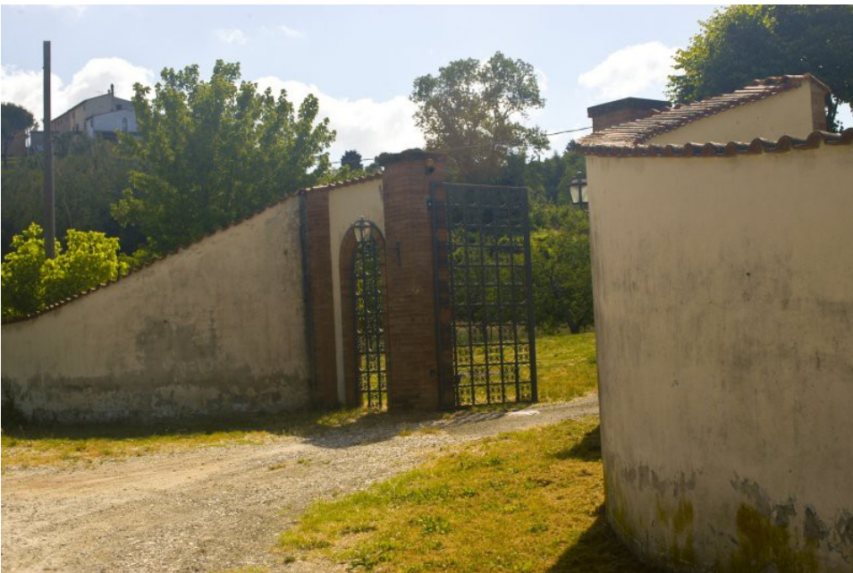
Nach ca. 5 Meter kommt rechts die Einfahrt...
